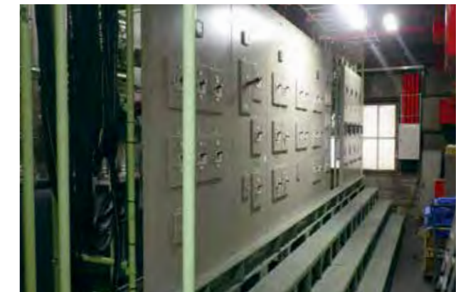
東大阪工場における冠水対策としての配電盤高上げ実施例
