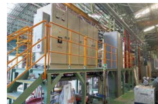
東大阪工場における冠水対策としての制御盤嵩上げ実施例
