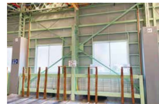
建屋柱の耐震補強
