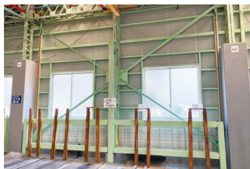
建屋柱の耐震補強
