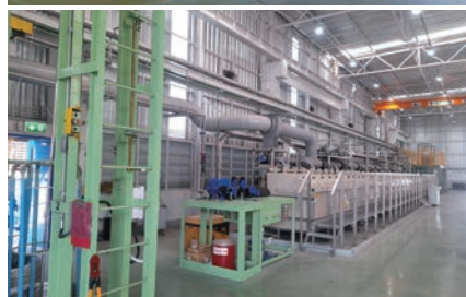
写真上：2023年5月に稼動開始した極細線用伸線機 写真下：2022年7月に稼動開始したニッケルメッキ設備
