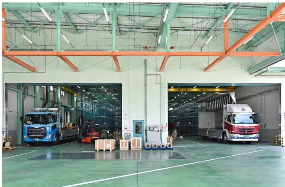
新倉庫正面出入口
